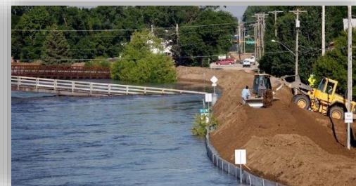
Устройство временных сооружений (дамб)
